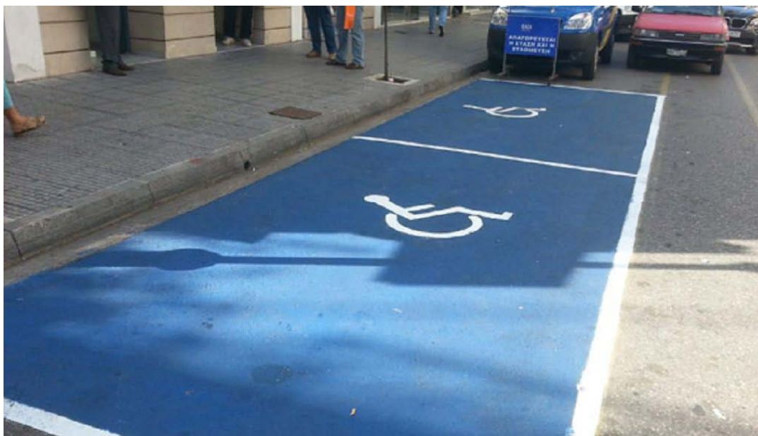
Εικόνα 22: Χρωματισμένες θέσεις στάθμευσης ΑμεΑ (πηγή: https://www.grtimes.gr/ )
