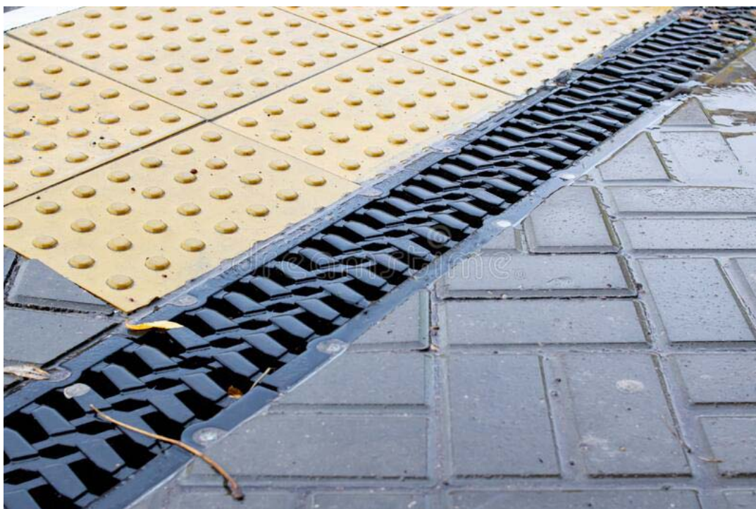
Εικόνα 3: Τοποθέτηση σχαρών στο πεζοδρόμιο (πηγή: https://es.dreamstime.com/ )
