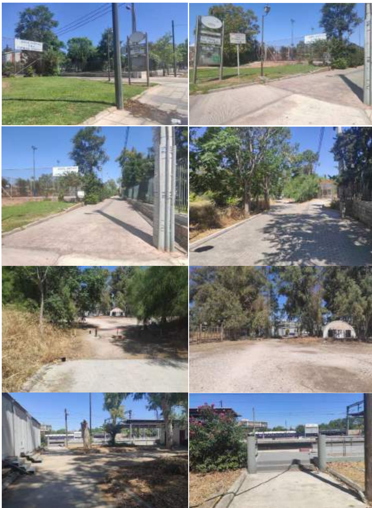
Φωτογραφία 6: Διάδρομος πεζή σύνδεσης της οδού Πειραιώς με τον σταθμό «Ρουφ» του ΟΣΕ/Προαστιακού
