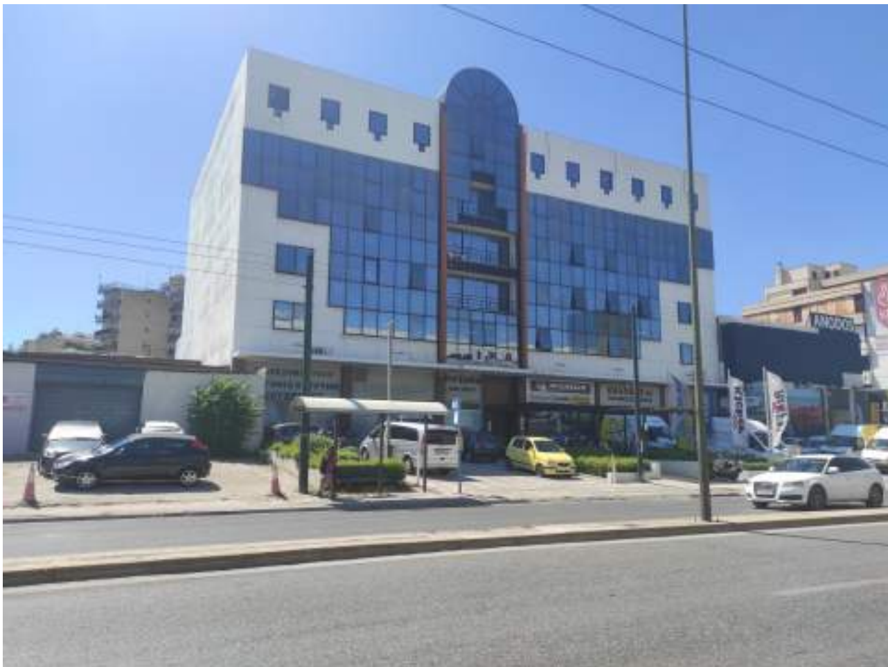
Φωτογραφία 5: Κτήριο του ΕΦΚΑ απέναντι από το Ο.Τ.59α & Στάση ΟΑΣΑ "ΥΠΟΥΡΓΕΙΟ" επί της οδού Πειραιώς 181 (στο ρεύμα ανόδου προς Αθήνα)
