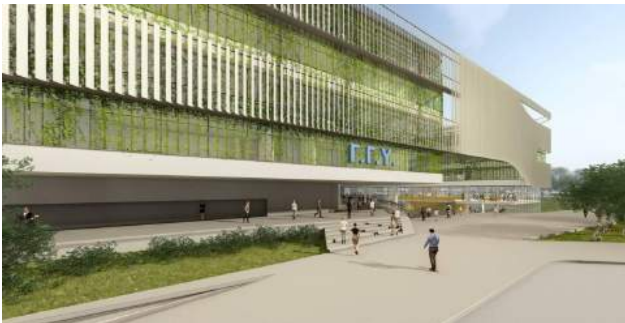
Εικόνα 6-3: Διπλό Βιοκλιματικό πέτασμα - εξωτερική επιδερμίδα περσίδων
