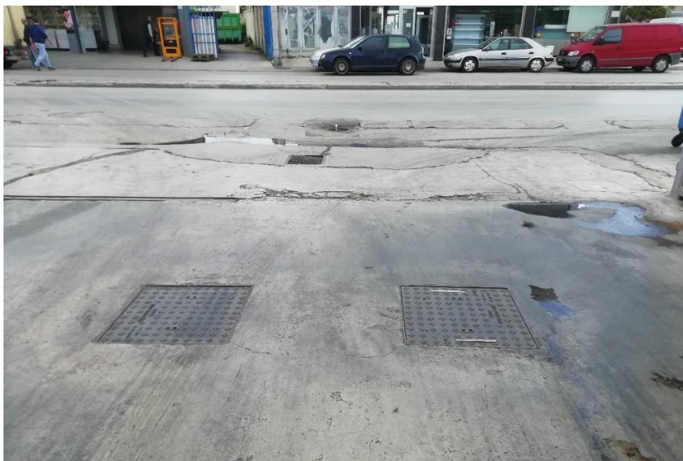
Φωτογραφία 14.7: Άποψη φρεατίου δειγματοληψίας των λυμάτων της μονάδας, λίγο πριν την διάθεσή τους στο δίκτυο ακαθάρτων της ΕΥΔΑΠ, στο όριο του γηπέδου της μονάδας, επί της οδού Πύργου.
