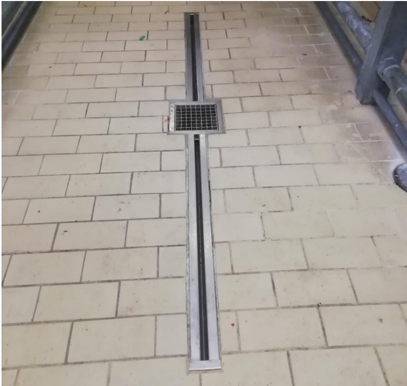
Φωτογραφία 14.23: Άποψη καναλιών αποχέτευσης νερών πλύσης εσωτερικών χώρων μονάδας.
